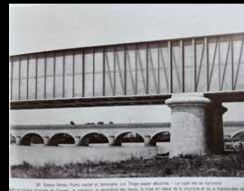
M. Bisson Bisson, Ponts, viaducs et terrasses, s.d. Trains passer alignés. - Le pont est en fer forgé.
